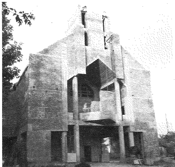
Il cantiere della chiesa che padre Simion sta costruendo.
